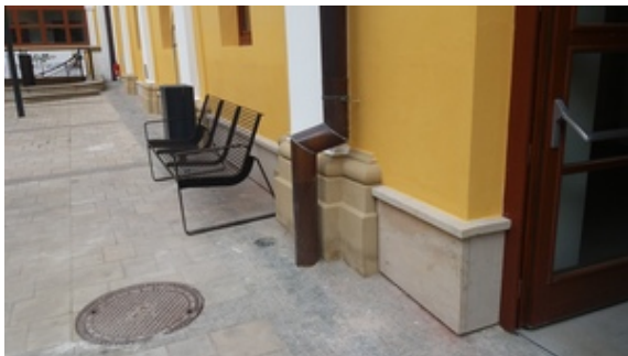
stav po sanaci
