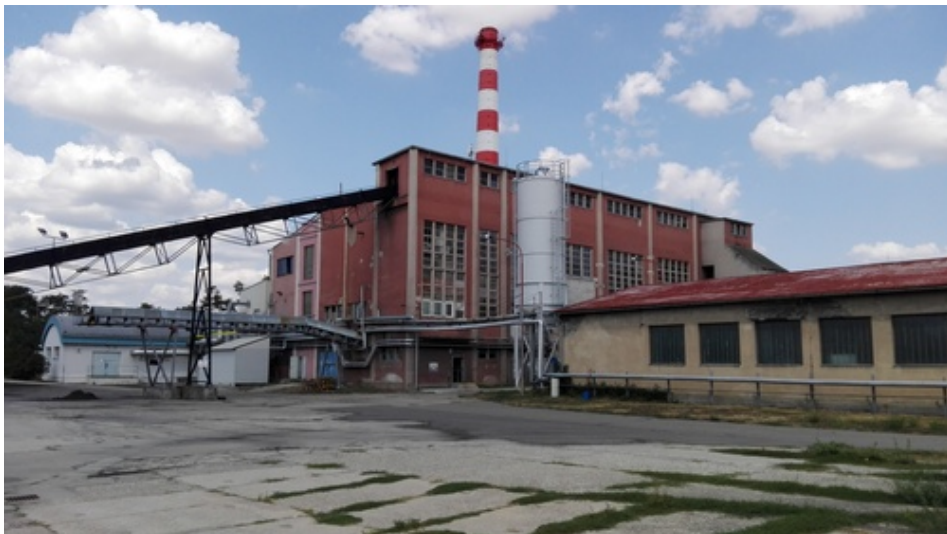
Foto: Tepárna Uherské Hradiště, zdroj CTZ s.r.o.
