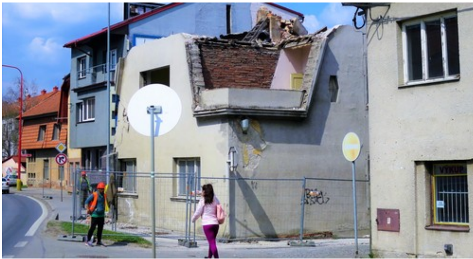
Dům č. 55 před demolicí
